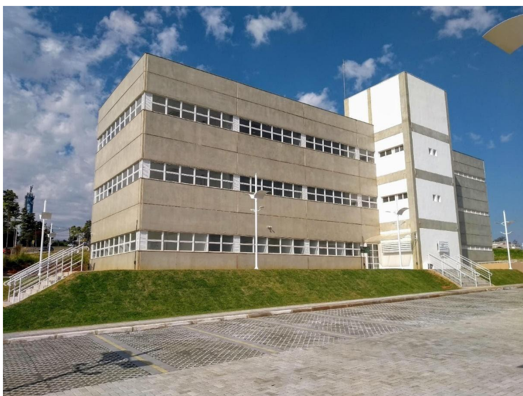
Conclusão do LIB, obra iniciada em 2011.
