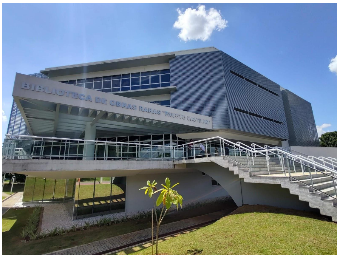
Conclusão Biblioteca de Obras Raras, obra iniciada em 2013.
